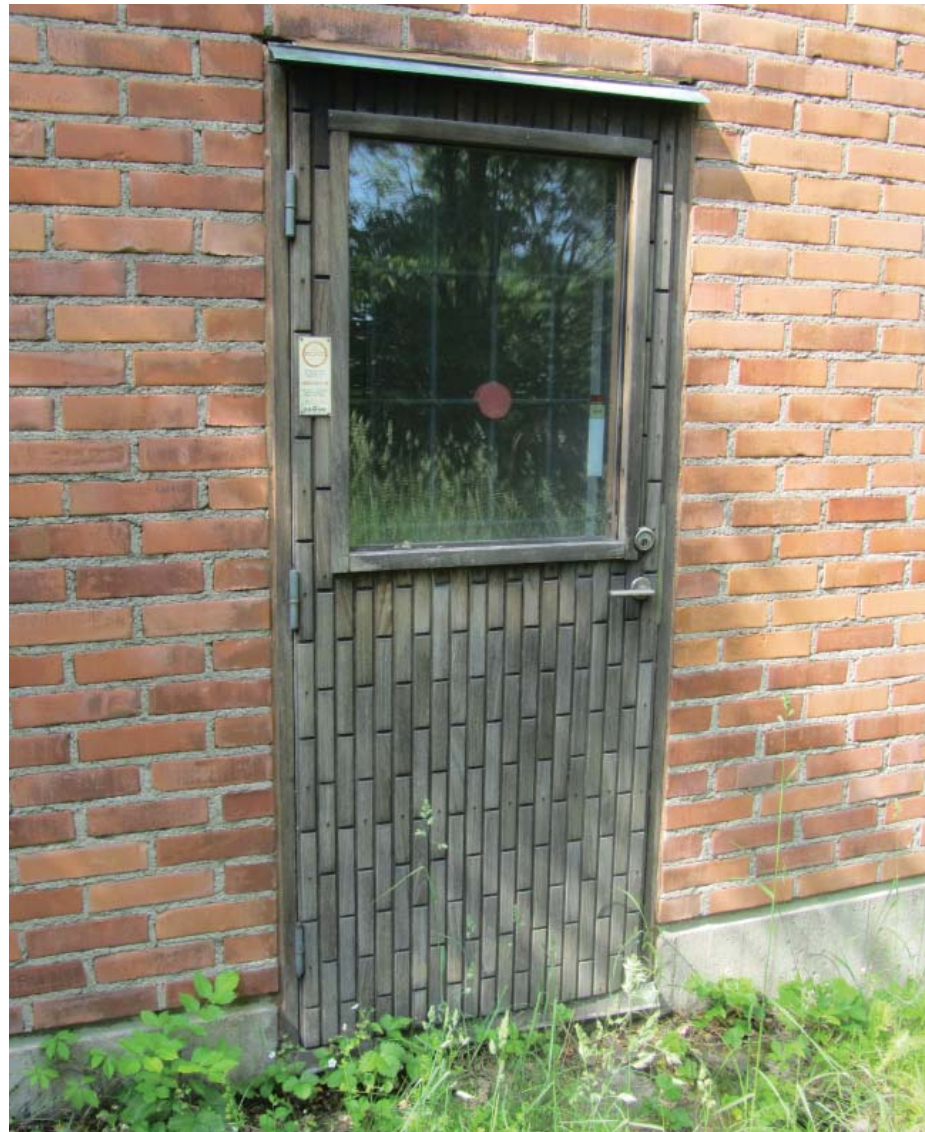
Ursprunglig dörr i den östra fasaden.
