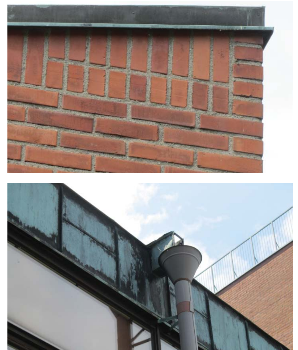
Fasaddetaljer; takfot i koppar och vattenutkastare.
