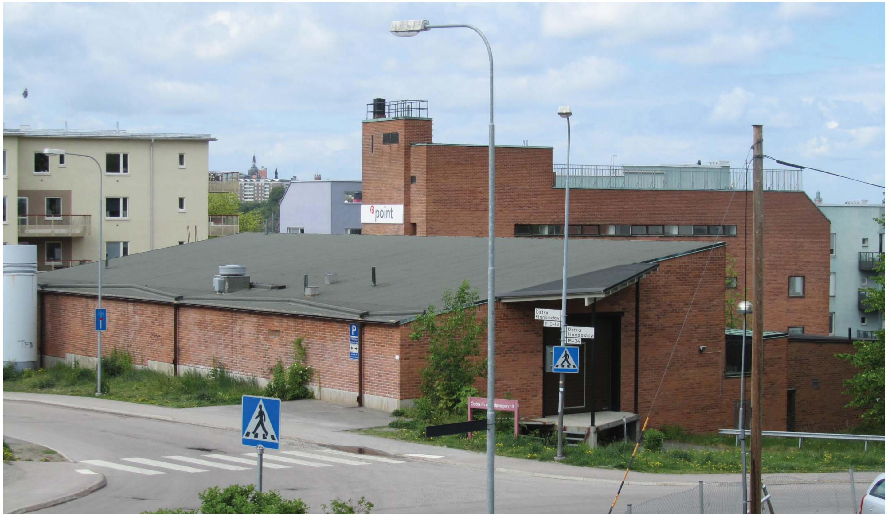
Den södra fasaden, bild tagen från sydost.
