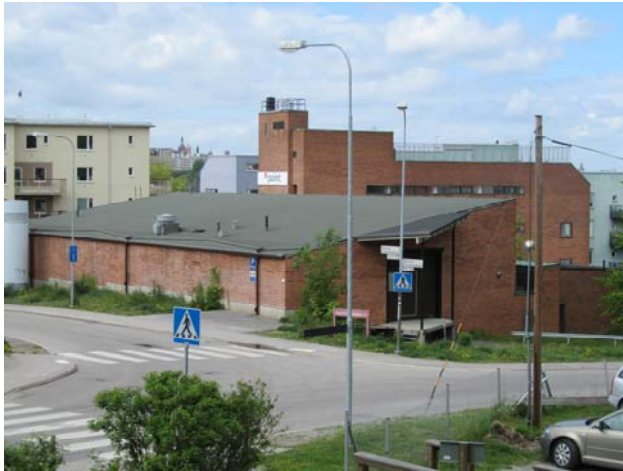
Den södra fasaden idag, bild tagen från sydost.
