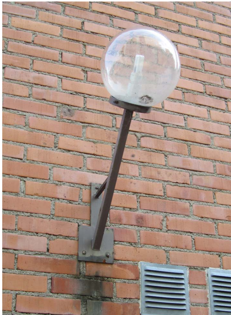
Befintlig armatur på den västra fasaden.
