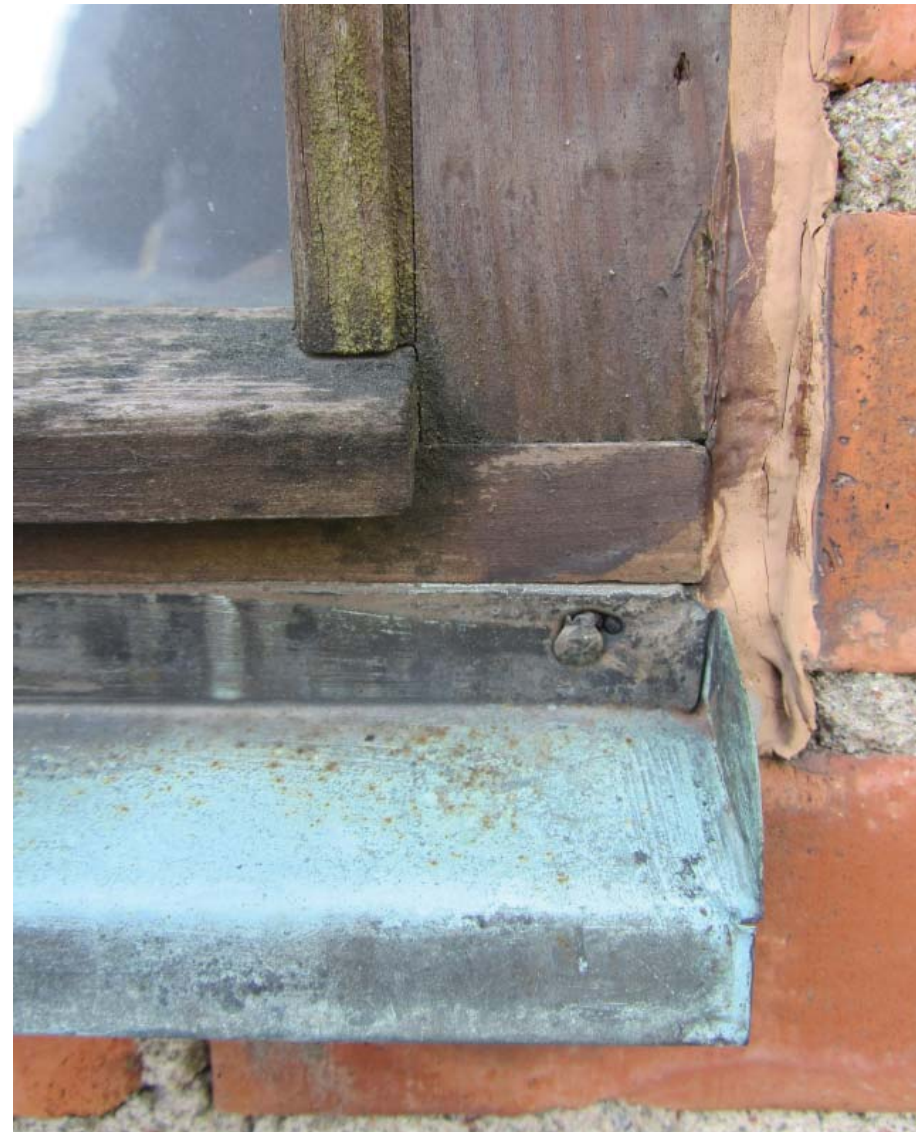
Fönsterdetalj på ursprungligt fönster.
