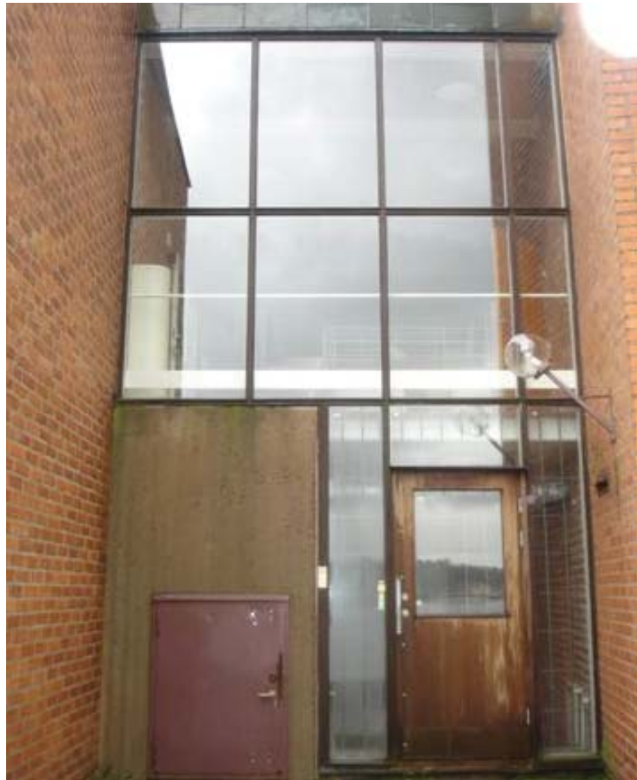
Den befintliga entrén i norrfasad.
