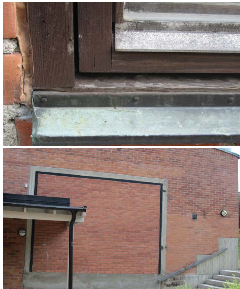
Fönsterdetalj droppbleck i plåt. Igenmurad industriport i den västra fasaden.
