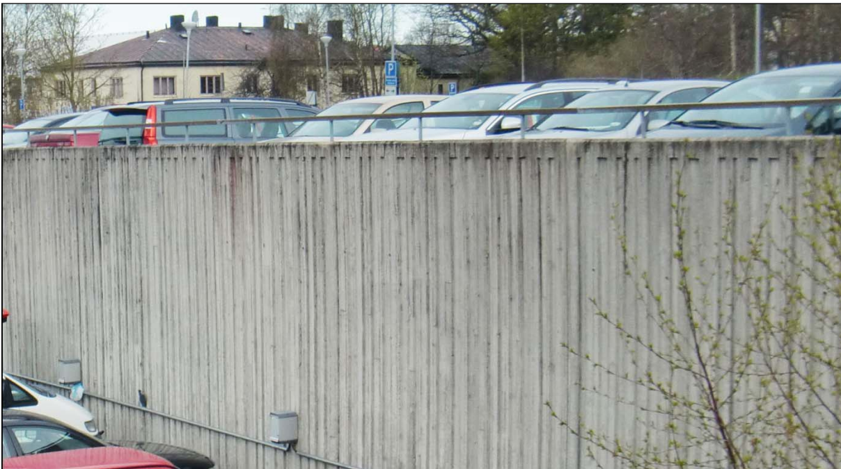
Figur 9 Befintlig stödmur på SL:s Busstoppens område
