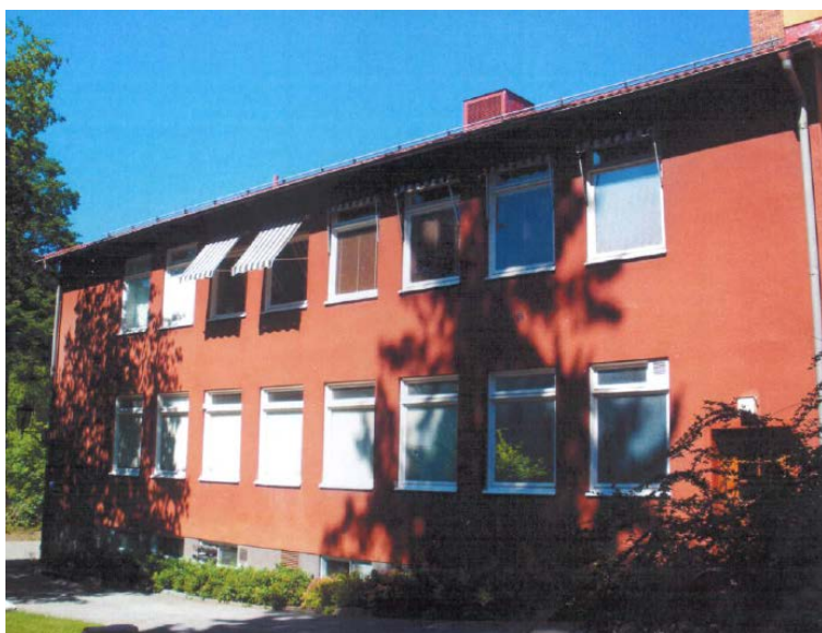
Dagens fasadutförande i sydväst
