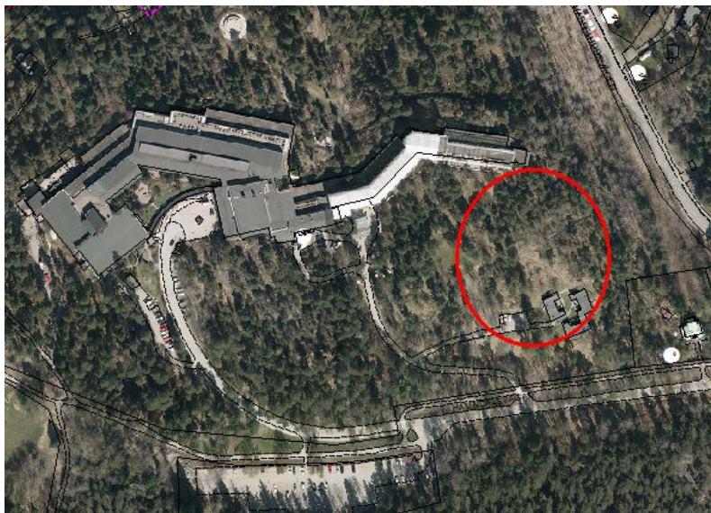
Flygfoto över Hasseludden Yasuragi samt inringad plats för Norges Hus. I södra delen av bilden ligger befintlig parkering som är tänkt att kompletteras med parkeringsdäck.
