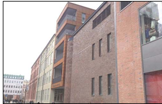
Avvikande volym av cortenplåt i Sundbyberg.
