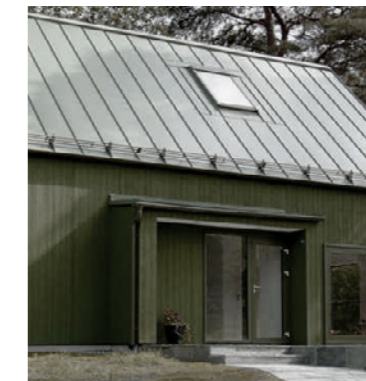
Exempel monokrom byggnad
