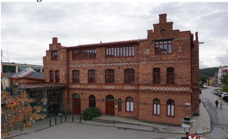
Ritningskontorets fasad mot norr.
