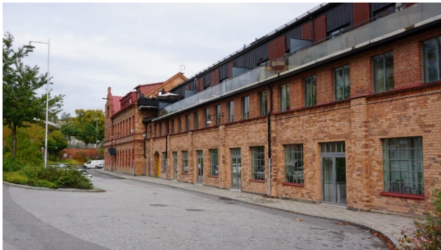
Bilden visar byggnadens tegelfasad mot väster med äldre industrifönster samt senare påbyggnader.
