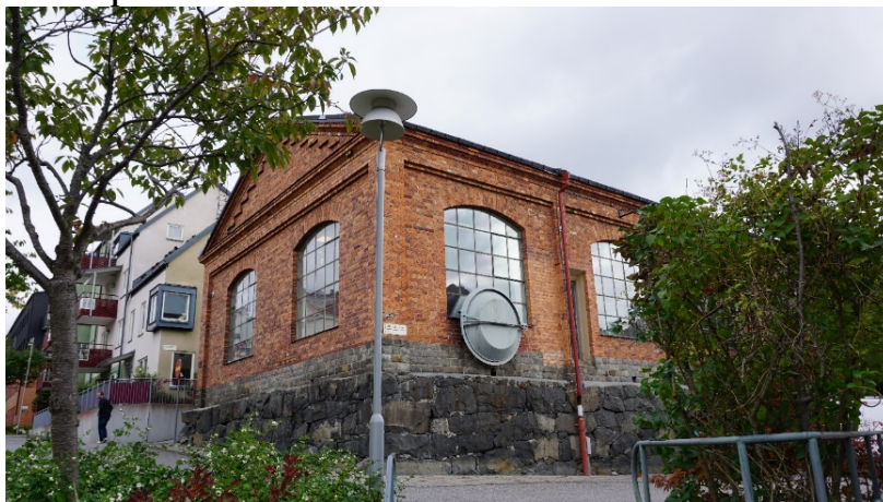
Pumpprovningshuset, byggnadens västergavel och del av södra fasaden med den tunga stensockeln och rusningstrumman i fönstret.
