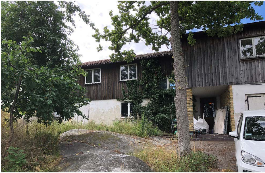
Figur 4: Huvudbyggnaden på Solsidan 55:10 är uppförd i souterräng med två våningar mot gatan och en våning mot vattnet. Souterrängsvåningen rymmer bland annat huvudentré och garage.
