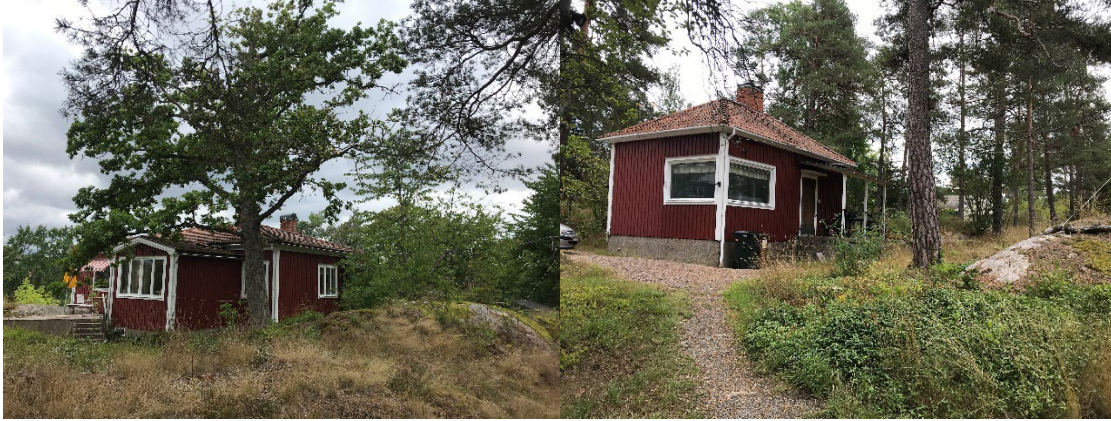
Tv: Huvudbyggnaden på Björknäs 10:124 med bevarandevärd ek intill. Th: Den mindre byggnaden omgiven av äldre tallar
