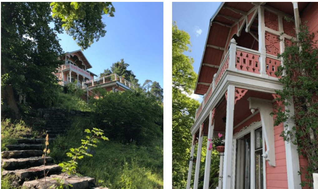
Figur 3: Huvudbyggnaden på fastigheten Björknäs 10:4. Bilderna visar huvudbyggnadens exteriör med lövsågade detaljer, samt den starka kuperingen på fastigheterna och tomtens grönskande karaktär.
