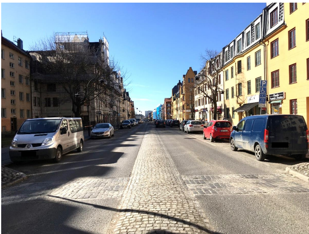
Figur 16. Exempel på överkörningsbar mittremsa som trafiklugnande åtgärd på Hägerstenvägen i Aspudden. Mittremsan delar upp körbanan i två fält som var för sig upplevs som smalare i jämförelse med en sammanhängande gemensam körbana. Mittremsan underlättar för oskyddade trafikanter att korsa gatan samtidigt som den försvårar omkörningar och oönskade vändningar.
