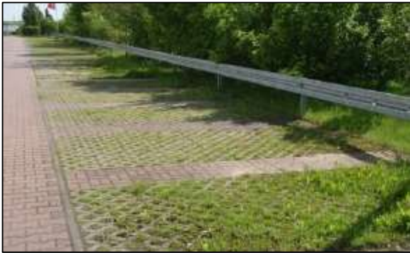
Figur 5-5. Exempel på genomsläppliga beläggningar med gräs. (Stockholms Stad, 2016)
