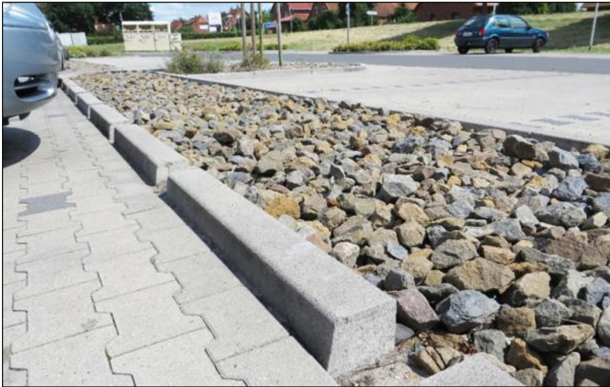
Figur 5.2. Exempel på makadamdike på parkeringsplats. (Svenskt Vatten Utveckling, 2019)
