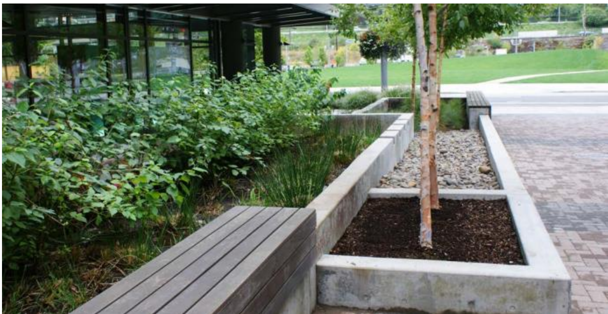
Figur 5.5. Exempel på seriekopplad växtbädd via överfall. (GrönNano, 2015)
