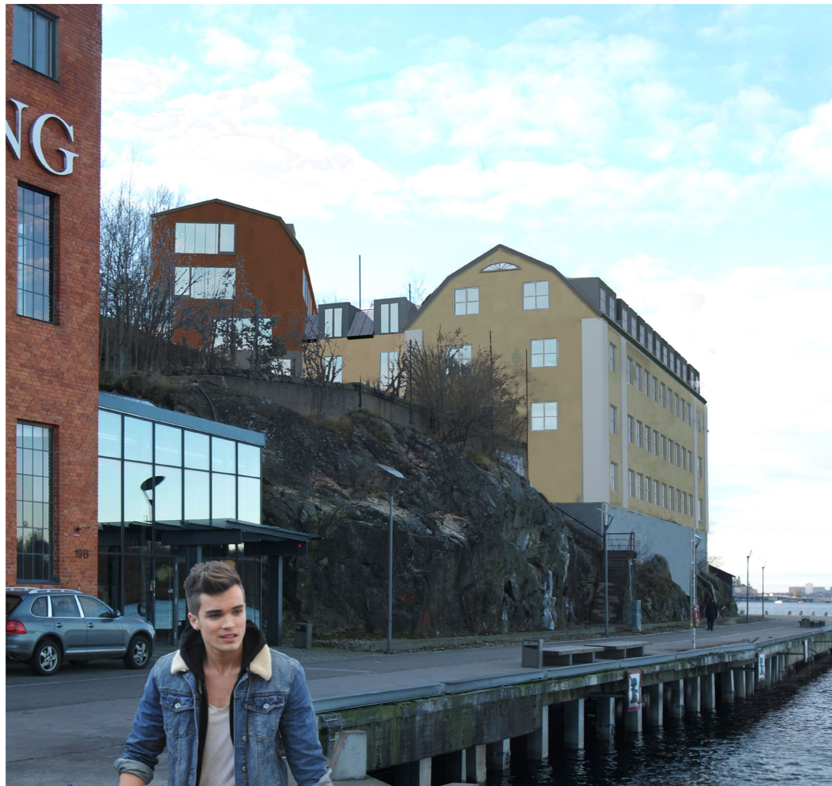
Det kompletterade kvarteret sett från kajen i öster en grå januaridag
