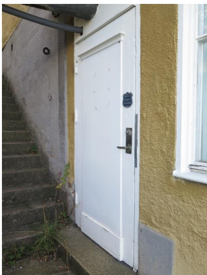
Originaldörr i souterrainvåningen
