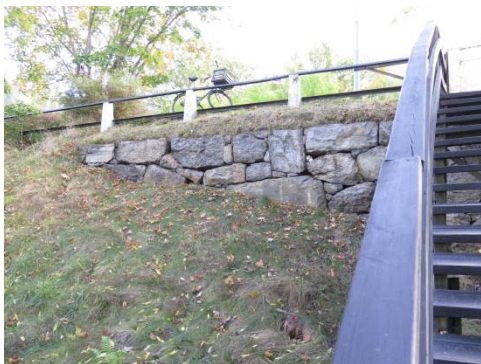
Bevarat murparti ivid kontorshuset
