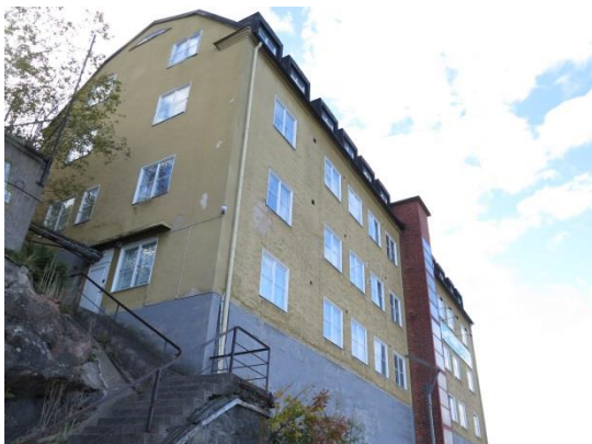
Öst- och norrfasad idag sett från kajen
