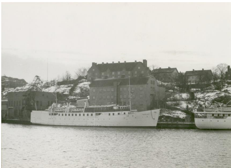
Byggnaden vintern 1965 sedan hissen tillkommit men ännu inga takkupor. Arbetarbostäderna syns på berget och ålandsbåten MS Marina ligger förtöjd vid kajen. Foto: Sjöhist.M.
