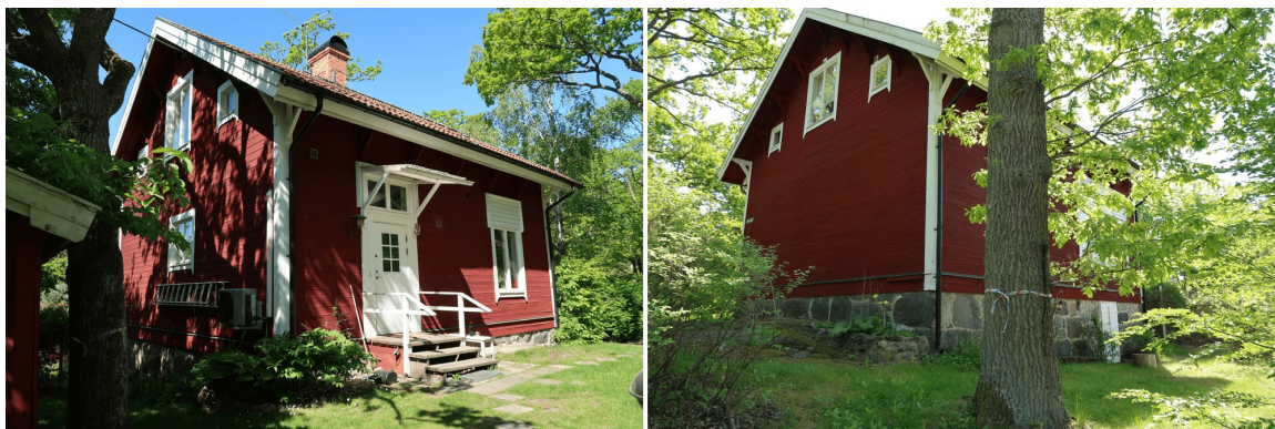
Figur 6: Till vänster annexets framsida, till höger baksidan med grund av tuktad fogad natursten och källardörr. Det markanta sadeltaket är väl framträdande. Bildkälla: Nacka kommun.
