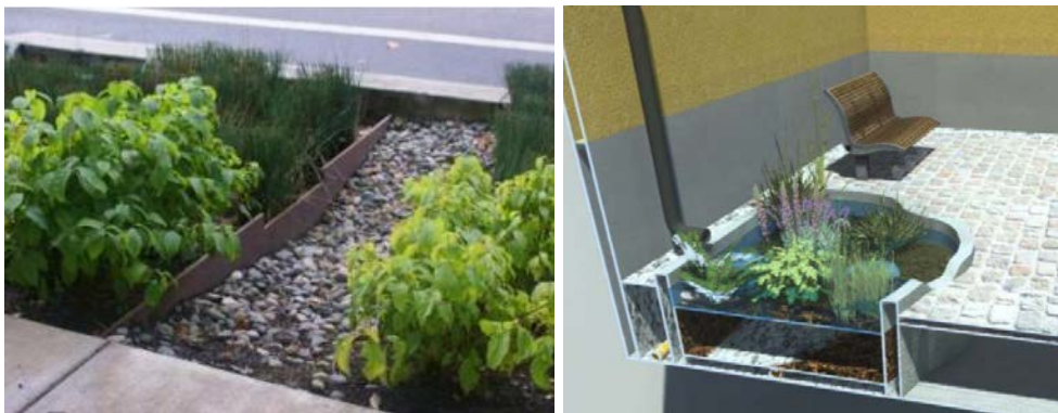
Figur 25. Exempel på regnbäddar hämtad från Nackas riktlinjer för dagvattenhantering.
