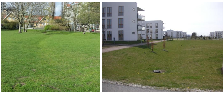
Figur 26. Exempel på svackdike/sekundär avledningsväg. Foto Ramböll.
