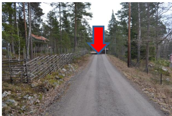
Bild 14 Bergbrinken österut. Höjdrygg som försvårar dagvattenavrinning och medför brant lutning i korsningen med Malmbrinken
