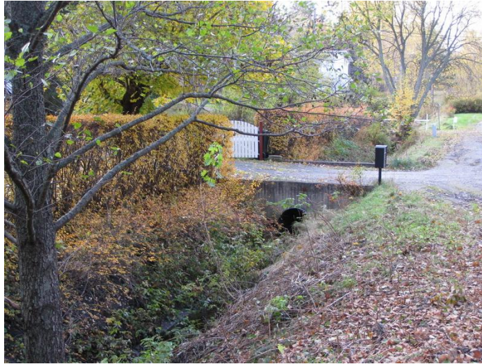
Bild 4 Dalvägen, infarter med brokonstruktioner. Sektioner 0/540 – 0/920
