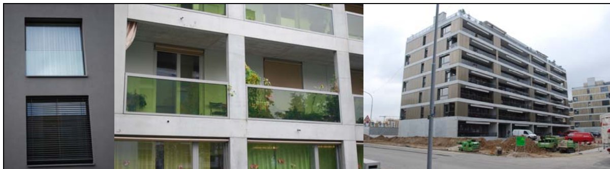
Räcken, solavskärningar, mm
