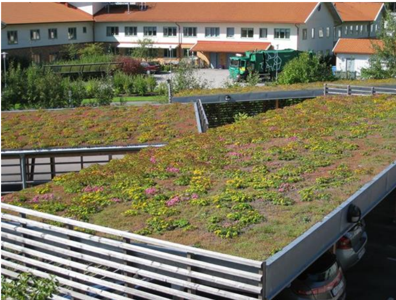
Figur 24. Grönt sedumtak på garagebyggnad i Kungsbacka. Bildkälla: VegTech AB.
