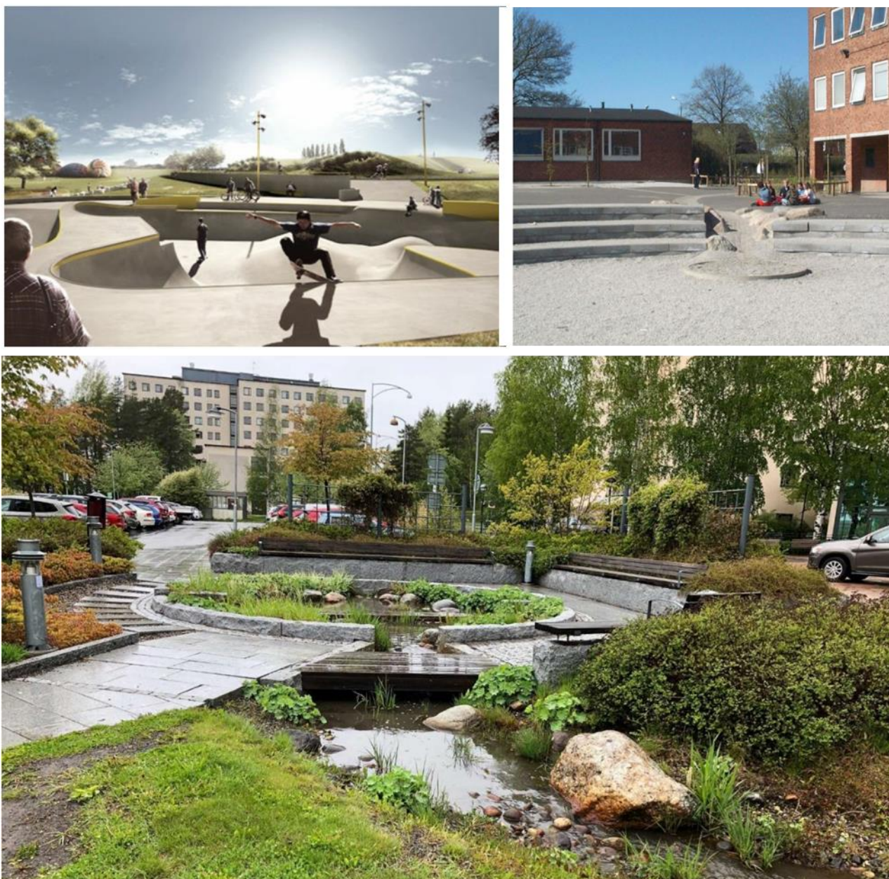
Figur 18. Översvämningsbara ytor. Överst till vänster, multifunktionell yta som vid kraftiga regn översvämmas och uppehåller skyfallsvatten (källa: Malmö Stad). Överst till höger, multifunktionell yta vid en skola i Malmö (källa: Stockholm vatten och avlopp). Nedre bilden, kombinerad översvämningsbar yta med dagvattenlösningar (källa: WSP).
