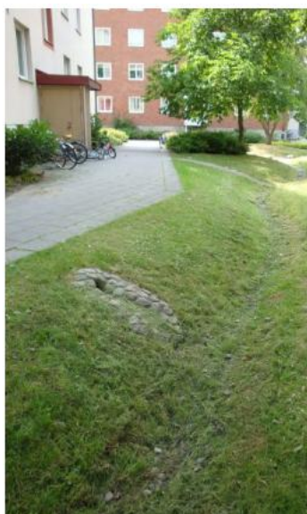
Figur 20. Svackdike längs gångväg. Källa: Sweco.
