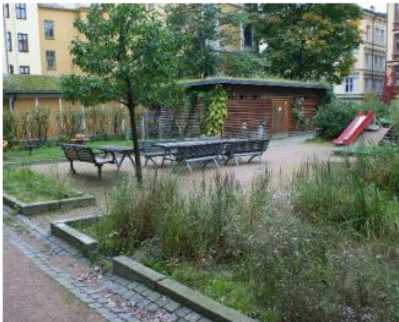
Figur 16. Utförande regngård vid innergård. Källa: Nacka Kommun, Riktlinjer och principlösningar för dagvattenhantering på kvartersmark och allmän plats.
