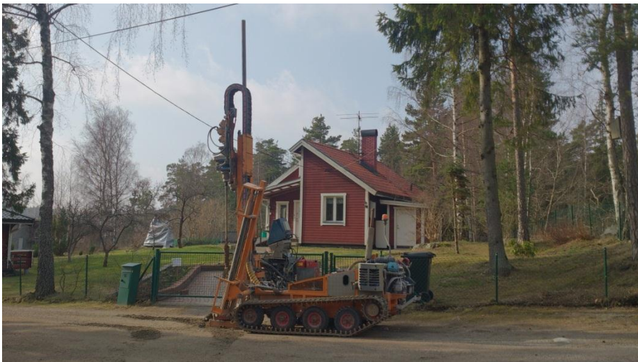
Borrsvagn vid undersökningspunkt SMS140.
