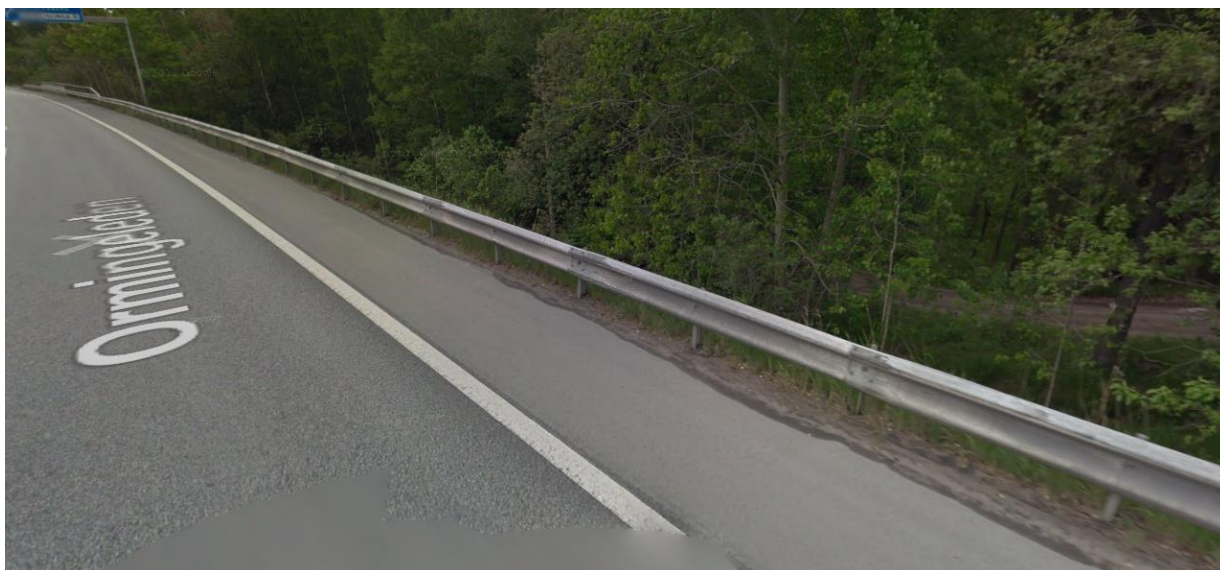
Figur 12. Avkörningsskydd finns mellan Ormingeleden och slänten mot området. I släntens slut kan Fågelstigen skymtas. Bildkälla: (Google, 2014)
