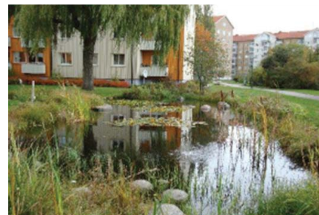
Exempel på dagvattendammar med naturlig utformning i bostadsnära bebyggelse, bild från dagvattenutredningen
