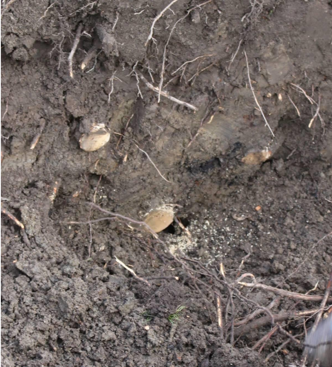
Bild 5. Korrekt beskurna rötter vid schakt.
