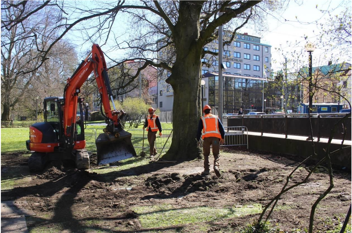
Bild 9. Avtagning av grässvål vid utförande av markvitalisering.
