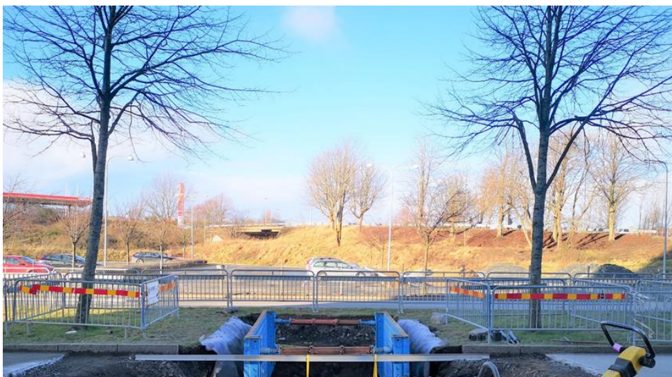
Bild 7. Användandet av spontsläde vid schakt intill träd.
