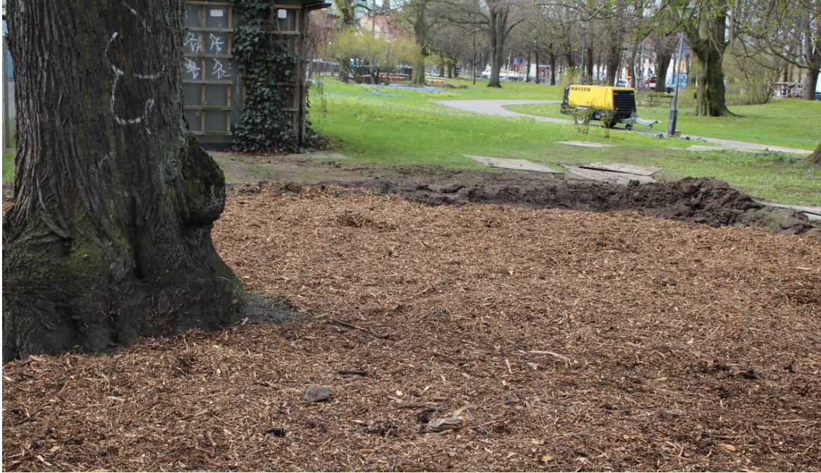
Bild 11. Färdigutlagt mulchlager vid markvitalisering.
