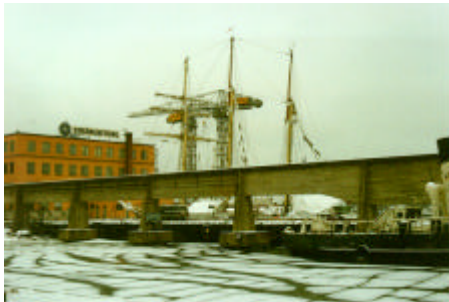
Vy längs kajen mot Strängbetongs byggnad
