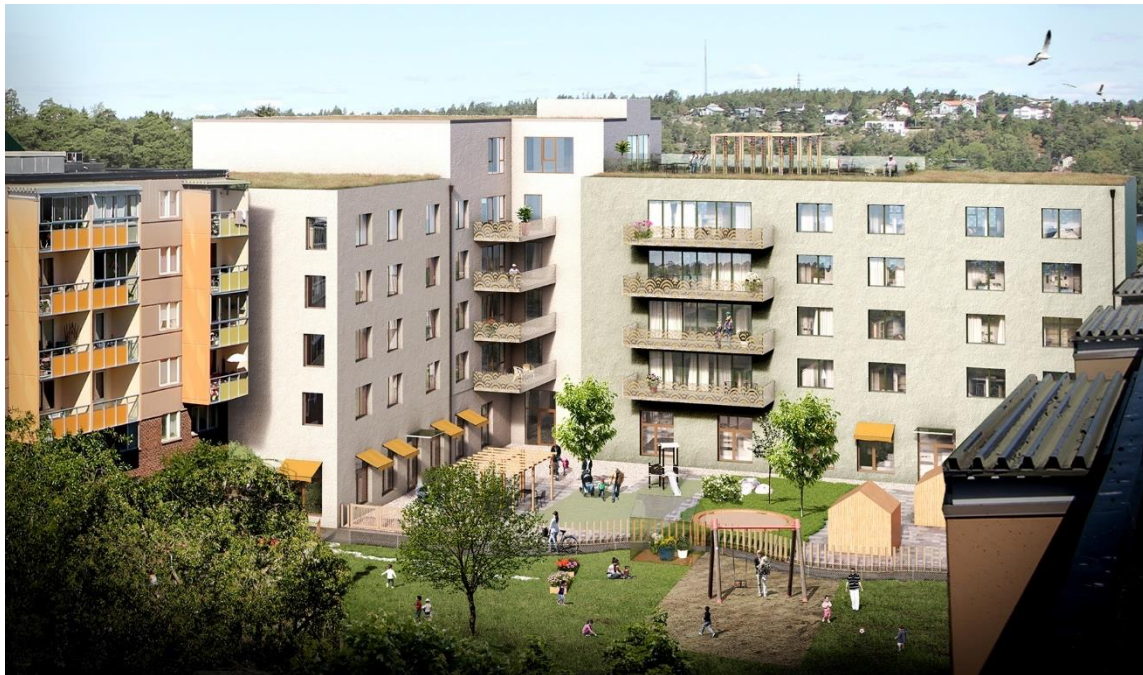
Förskola och vårdboende (gård 1, kvarter B). Förskolegården upptar yta även på befintlig bostadsgård. Utformningen kan komma att ändras. (Bild: Brunnberg & Forsbed)
