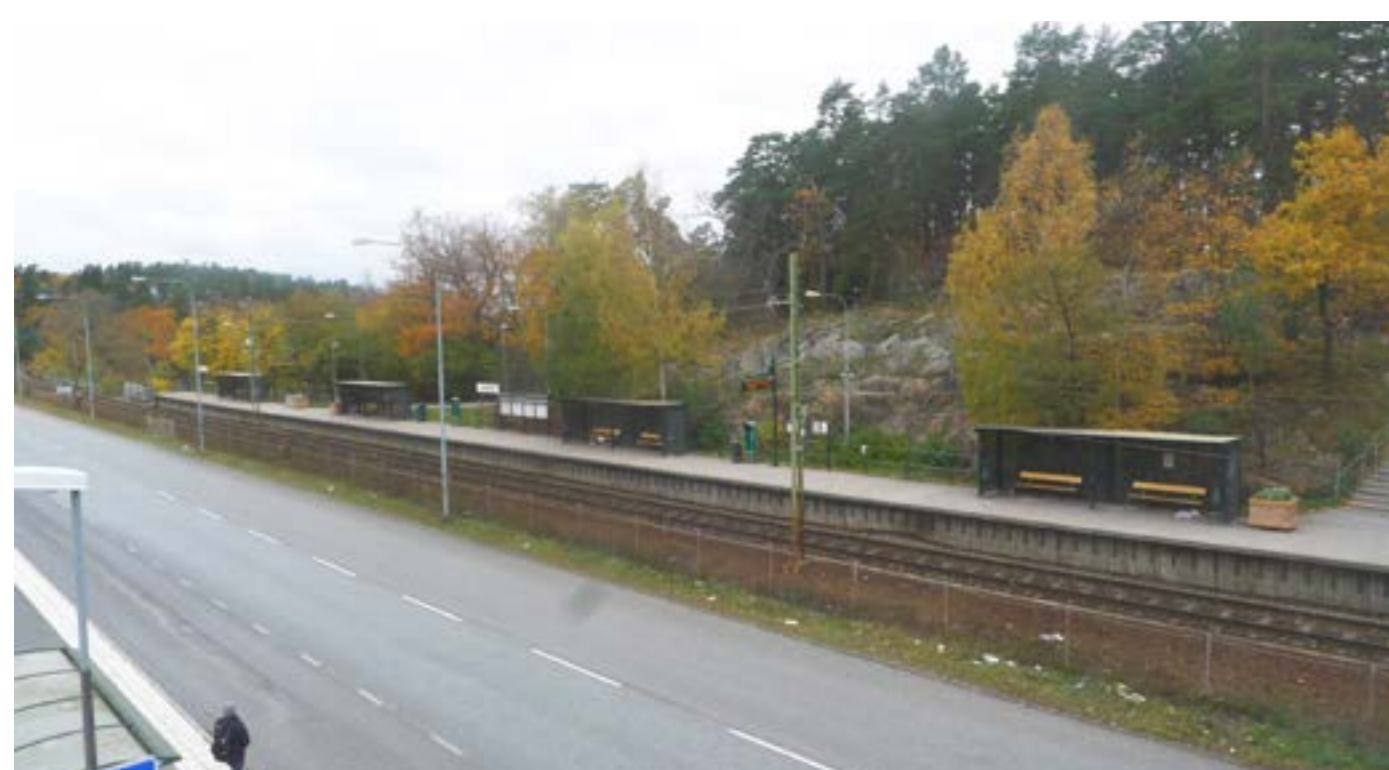
Stationen idag sett från gångbron.
