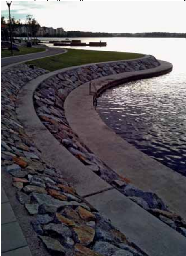
Exempel på gradängar ner i vattnet vid Hornsberg
