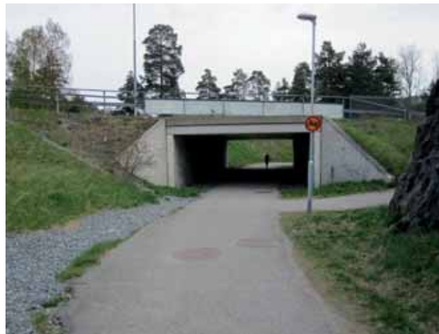
Gångtunnel mellan Fisksätra och Erstavik
