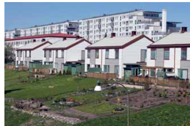
Exempel på komplettering av befintligt bostadsbestånd i Gårdsten
