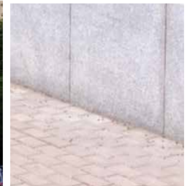
Sockel / entréer i sten.
