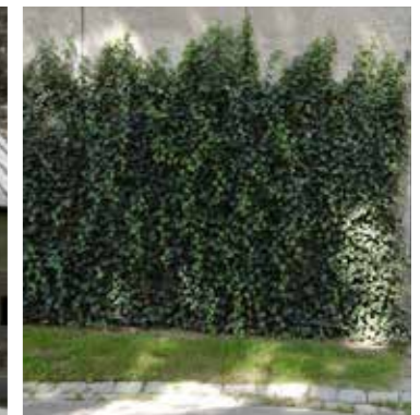
Spaljé framför sockel fasad.
