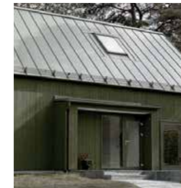
Exempel monokrom byggnad
