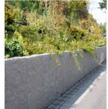
Exempel stödmur i granit / blocksten möte sluttning
