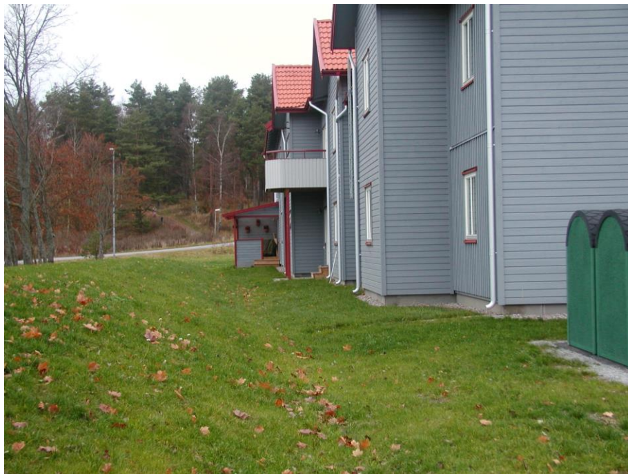
Figur 6. Exempel på bostäder med utkastare på stuprör. I detta fall med rännalsten som avleder vattnet från byggnaden till gräsbevuxet svackdike. Källa: WRS.
