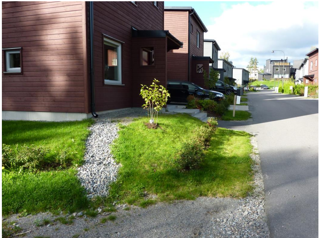
Figur 5. Exempel på bostäder med utkastare på stuprör. Här med avledning till infiltrationsdike med porös fyllning och dränering utmed gata. Källa: WRS.
