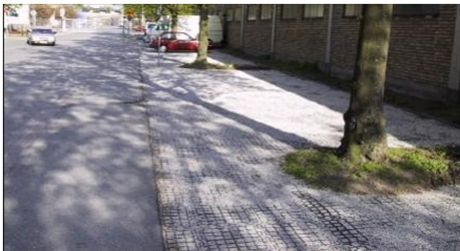
Figur 8. Markparkeringar med så kallade Pelle-plattor. Foto: Ulf Thysell, VASYD/Malmö stad.
