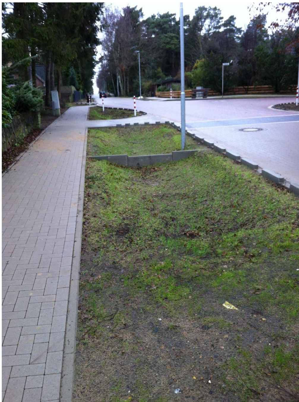
Figur 10. Öppet dike för dagvatteninfiltration och fördröjning samt gata med öppnad kantsten i Tyskland. Foto: Dimitry van der Nat, WRS.
