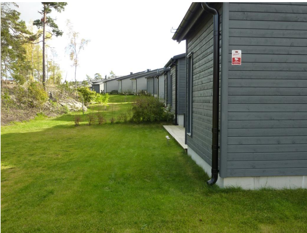
Figur 4. Exempel på bostäder med utkastare på stuprör, här för infiltration i de uppfyllda tomternas gräsmatta. Källa: WRS.
