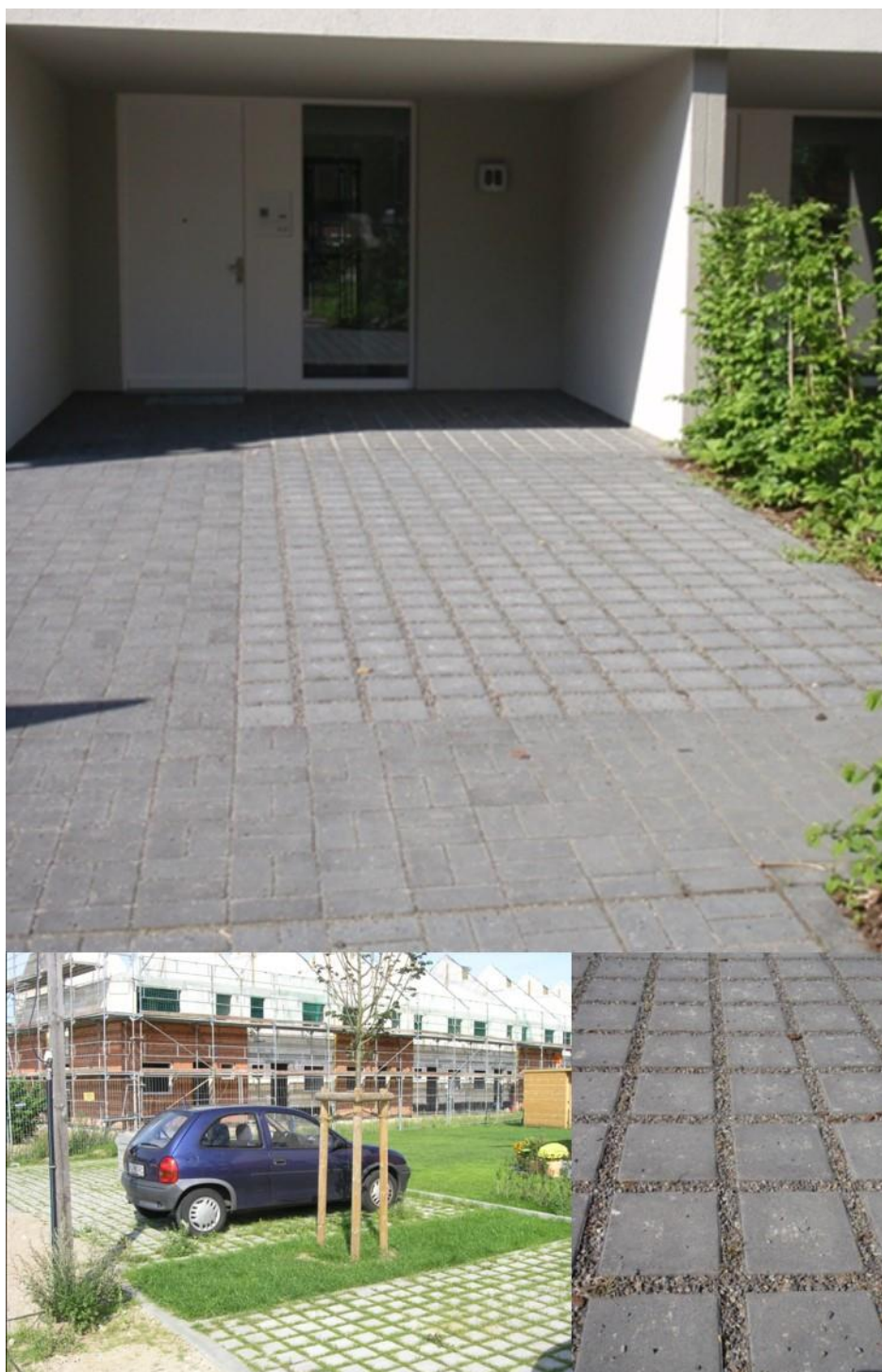
Figur 7. Markparkeringar utformade med marksten med gles, genomsläpplig fog. Källa: WRS.
