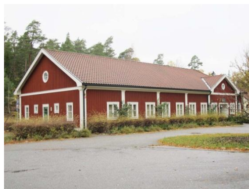
Kiblstugan som ligger mellan stallet och vaktmästarbostaden. (Byggnad nummer 3)
