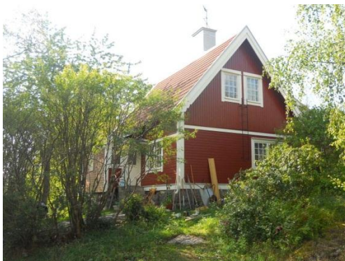
Vaktmästarbostaden strax norr om huvudbyggnaden. (Byggnad nummer 7)
