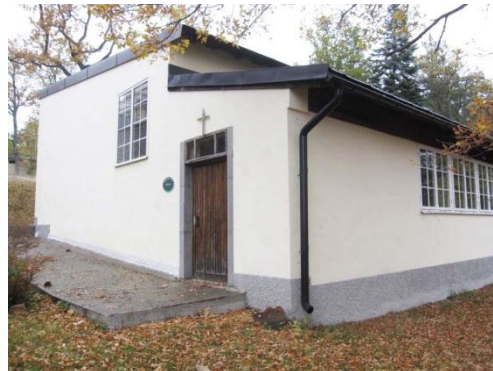
Kyrkan sydost om huvudbyggnaden. (Byggnad nummer 6)
