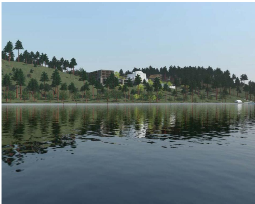
Huvudbyggnaden med vård- och omsorgsboende till vänster sedd från Baggensfjärden.
