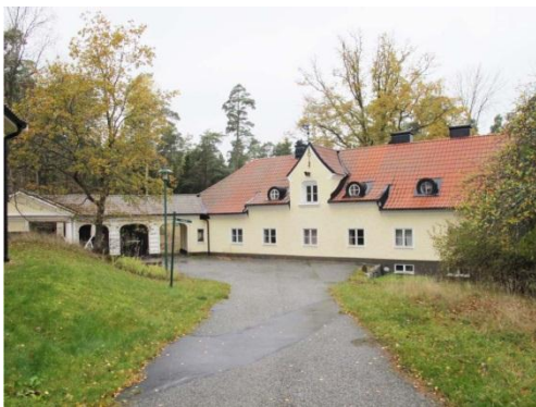
I norr ligger stallbyggnaden och garaget. (Byggnad nummer 4)
