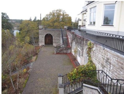
Del av terrasanläggningen. (Byggnad nummer 5)
