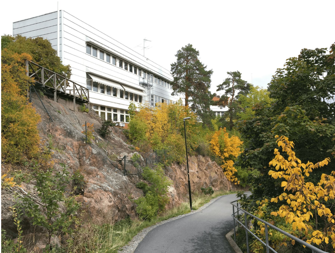
Figur 24: Foto taget från gång- och cykelvägen mot fastigheten Sicklaön 37:45. Bilden visar den branta bergsskärmningen, befintlig byggnad, befintlig uteplats och stängsel.
