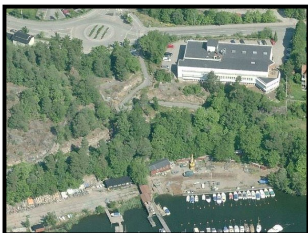
Figur 13 Befintlig byggnad och vegetation i detaljplanen.
