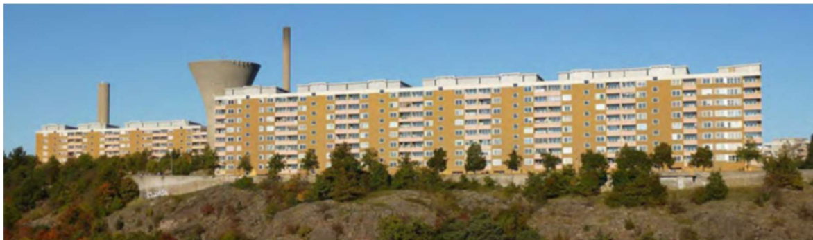
Figur 3. Foto. Vy från Alphyddan mot Henriksdalsberget. Den borgliknande bebyggelsen som tillsammans med skorstenar och vattentorn bildar ett påtagligt landmärke i stadsbilden. Bild: Nacka kommun
