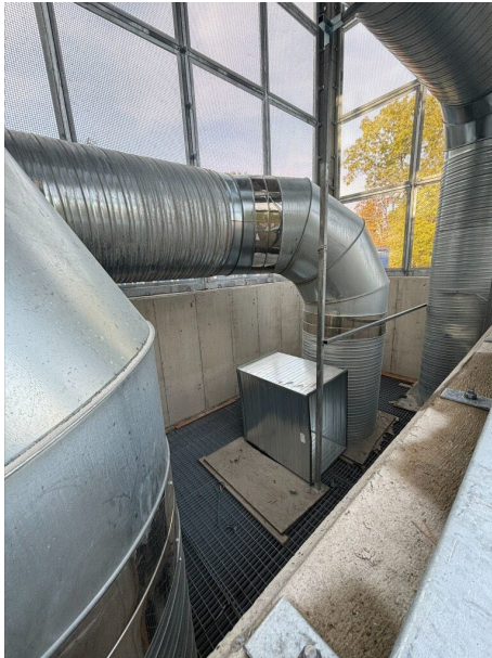
Figur 3 Tillfälliga avluftskanaler dras via ventilationstornet, insida torn.
