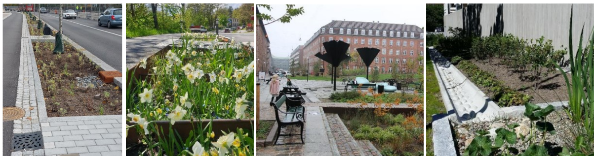
Figur 5-1. Exempelbilder på nedsänkta regnbäddar med vegetation, på gata, torg och kvartersmark. Foton från Anvisningar för dagvattenhantering (Nacka kommun, 2018).
