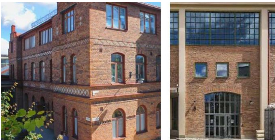
Industribebyggelse från det förra sekelskiftet i Järla sjö: Turbinhallen tillhörande Alfa Laval's ångturbinfabrik. Foto: Semrén & Månsson
