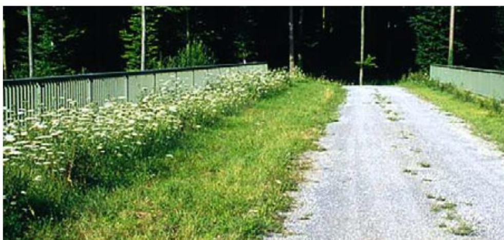
Figur 1. Remsa av vegetation vid sidan av en skogsbilväg på en bro. Foto: Vägverket och Banverket (2005).
