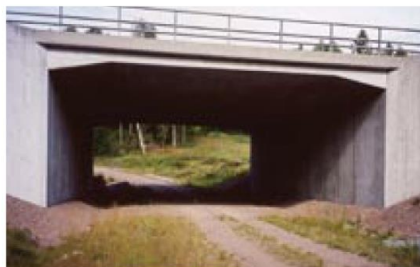
Figur 2. Bred underpassage med vegetation längs sidorna av vägen. Foto: Vägverket och Banverket (2005).
