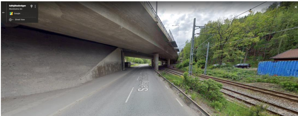
Figur 22. Underpassage som eventuellt kan vara ekologiskt funktionell för olika djurarter, förstärkningsåtgärder anses vara nödvändiga. Bild: Google Maps.
