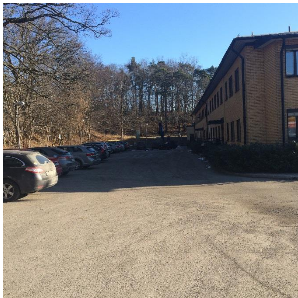
Foto 1. Huvudbyggnad med parkering, vy mot öster.
