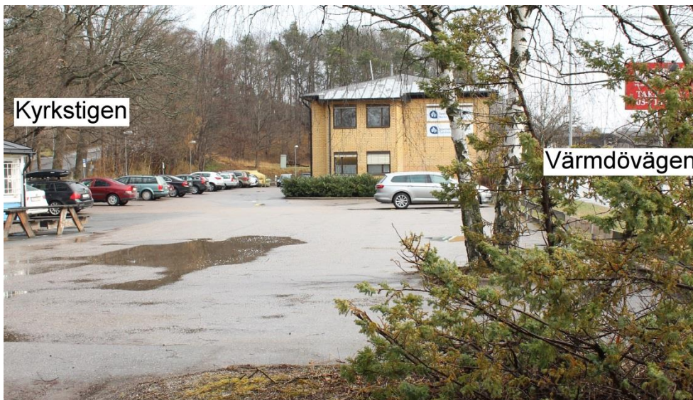
Figur 4. Utredningsområdet fotat från utredningsområdets västra gräns. T.h. Värmdövägen och t.v. den mindre vägen Kyrkstigen. Thaiiosk delvis synlig t.v. och bakom tegelbyggnaden skymtas fastigheten Sicklaön 40:11, som utgörs av en trädbevuxen kulle.
