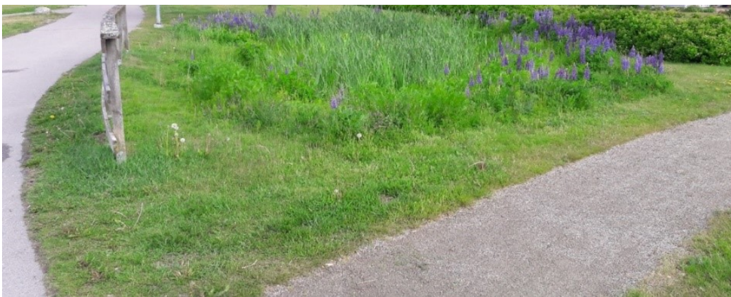
Figur 15. Nedsänkt grönyta för hantering av dagvatten från anslutande ytor. Vatten leds in till bädden via markavrinning på bred front då anslutande ytor skevas mot bädden.
