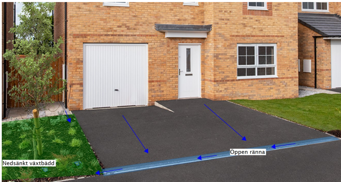
Figur 19. Exempel på dagvattenhantering vid uppfarter med öppen ränna som samlar upp avrinning från hårdgjord yta. Avrinning leds sedan till nedsänkt växtbädd för bevattning/fördröjning/rening. 7
