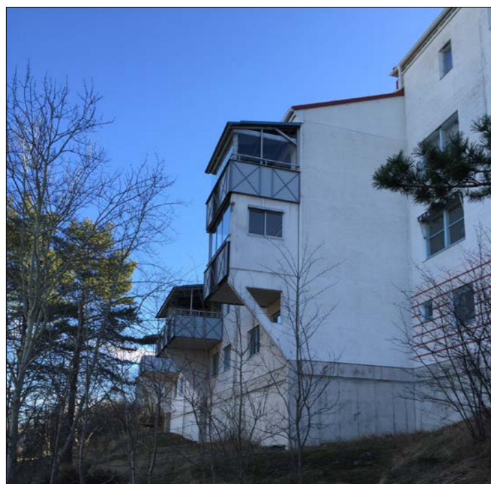
En hög sockel möter naturmarken på baksidan av storgårdskvarteret. Fönsterbandet går en våning upp. Inga direkta kopplingar in till gården eller ner på gatan.
