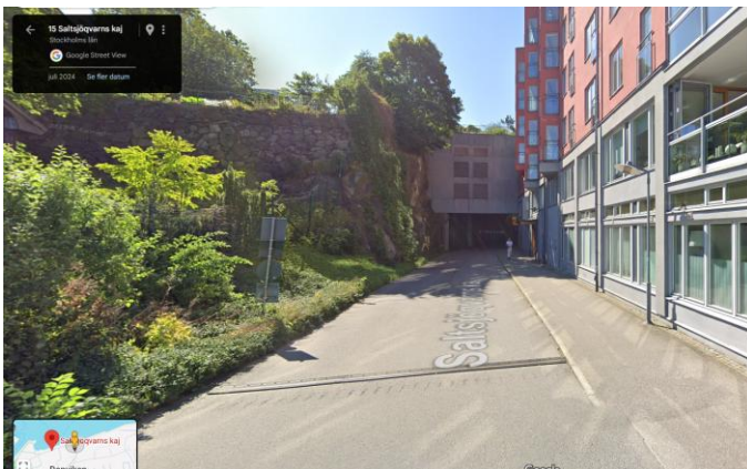
Figur 6. Del av Saltsjöqvarns kaj som leder från kajen till tunneln, sett från norr, Google maps 2025.
