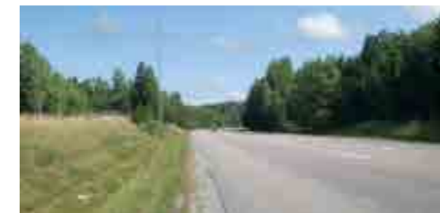
Bred vägbana på Gamla Skärgårdsvägen (väg 622)
