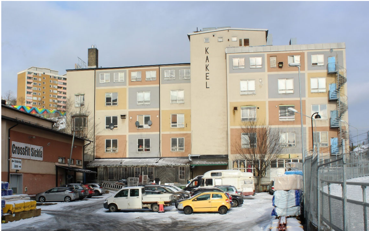
Klintens färgfabrik sedd från söder. Bild Nacka kommun
