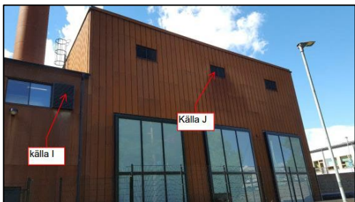
Figur 2. Panncentral med 2 av bullerkällorna.
