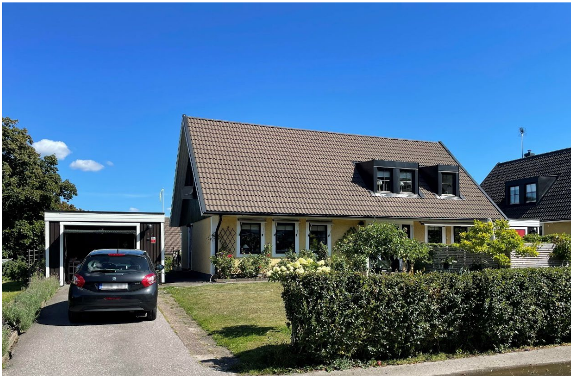
Figur 5. Bostadshuset och tillhörande garagebyggnad på Rösunda 38:15 sett från Kommendörsvägen. (Nacka kommun, 2024)
