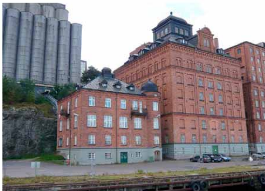
Hus 01 sett från nordost.
