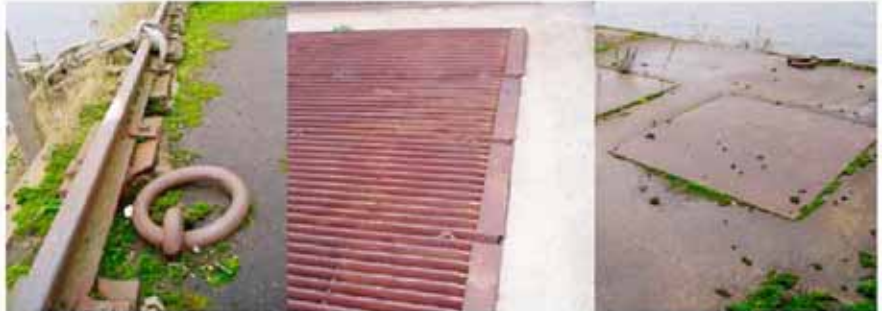
Exempel: Befintliga material som räls, galler och luckor ska återvändas
