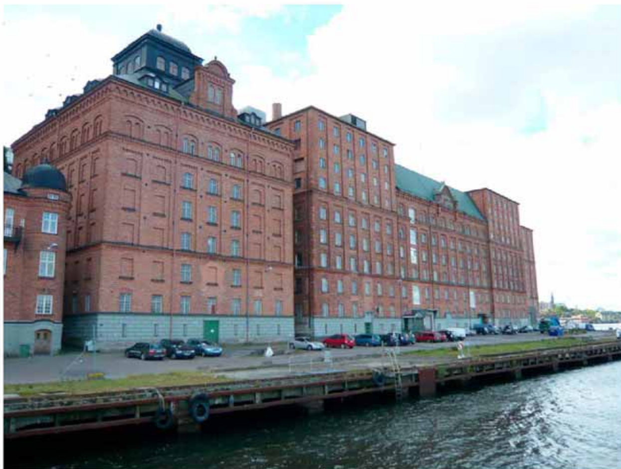
Kajen idag. Den yttre betongkajen är i dåligt skick och måste förstärkas.
