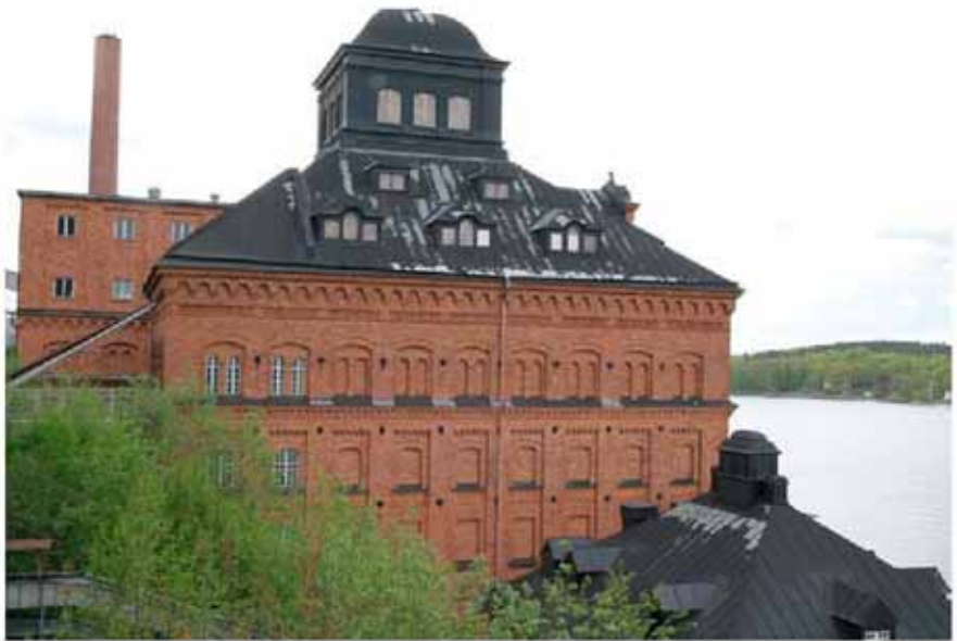
Fasad och tak mot öster.
