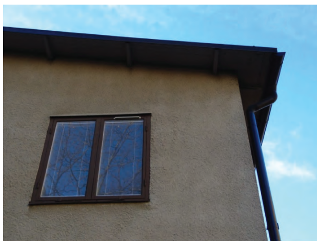
Detalj av fasad med utskjutande taksprång. Synliga taksparrar och tunna plåtavtäckningarna ger taket ett lätt uttryck. Nedanför ett tvåluftsfönster som ligger i liv med fasadytan. Från början var fönstren vita och fasaderna slätputsade i en ljusare kulör.
